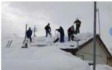
冬季の雪下ろし作業
