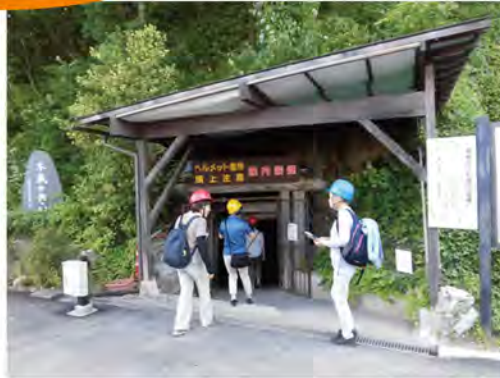
象山地下壕 第二次世界大戦の末期、軍部が本土決戦の最後の拠点として、極秘のうちに建設された象山地下壕入口。
