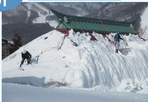
安全第一に(ザイル、安全帯を使用)4人一組で連日一人暮らし世帯を中心に雪下ろし作業に就業しています
