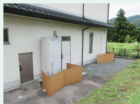
⑥段ボールを利用した屋外機械などの飛び石保護
